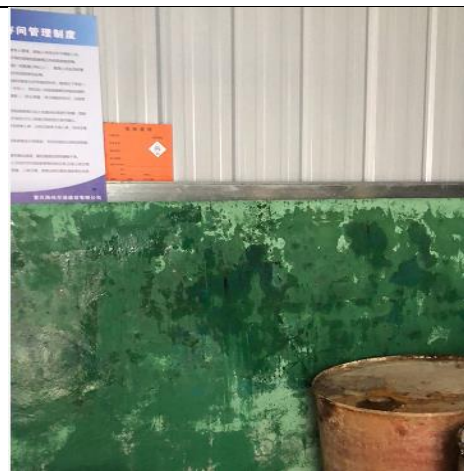
危废暂存间内部墙面防渗
